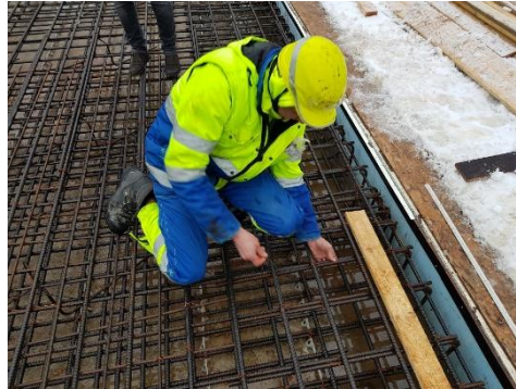
Temperatuuriandurite paigaldamine
