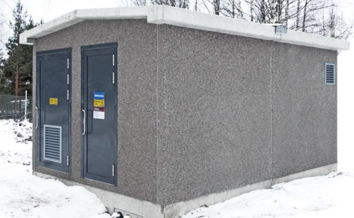
Betonimuuntamo BeMu 2. Kaksi muuntamomodulia peräjälkeen.
